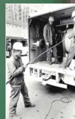
Instalación de fibras ópticas en la ciudad de Chicago
