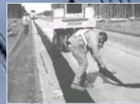
Construcción de carretera pavimentada con asfalto
